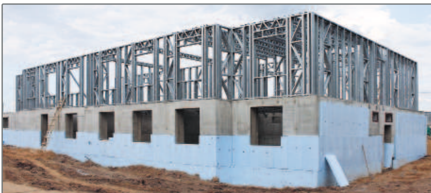
МОНТАЖ МЕТАЛЛОКАРКАСА 4-ЭТАЖНОГО ЖИЛОГО ДОМА п/н «Гармония», Нальчинская обл., 2013 г.
