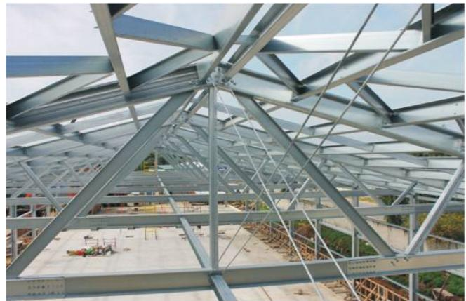
Здания СТЕРК® с каркасами из холодногнутого оцинкованного профиля, с 2012 года выпускаемые заводом "Андромета", отличает сочетание эксплуатационной надежности с технологичностью монтажа, оптимальными весовыми характеристиками и высоким уровнем коррозионной и огнезащиты. Это достигается за счет новаторских конструктивных решений и применения уникального производственного оборудования, специально изготовленного для реализации этих решений одним из лучших мировых поставщиков.
