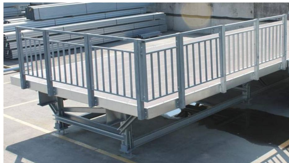
Конструкции платформы выполнены из негорючих материалов. Устойчивость конструкций при пожаре обеспечивается конструктивными мероприятиями, заключающимися в применении несущих конструкций серии СТЕРК®, с пределом огнестойкости R15 по СНиП 21-01-97 (имеется сертификат и заключение ВНИИПО о пределе огнестойкости конструкций СТЕРК®).
