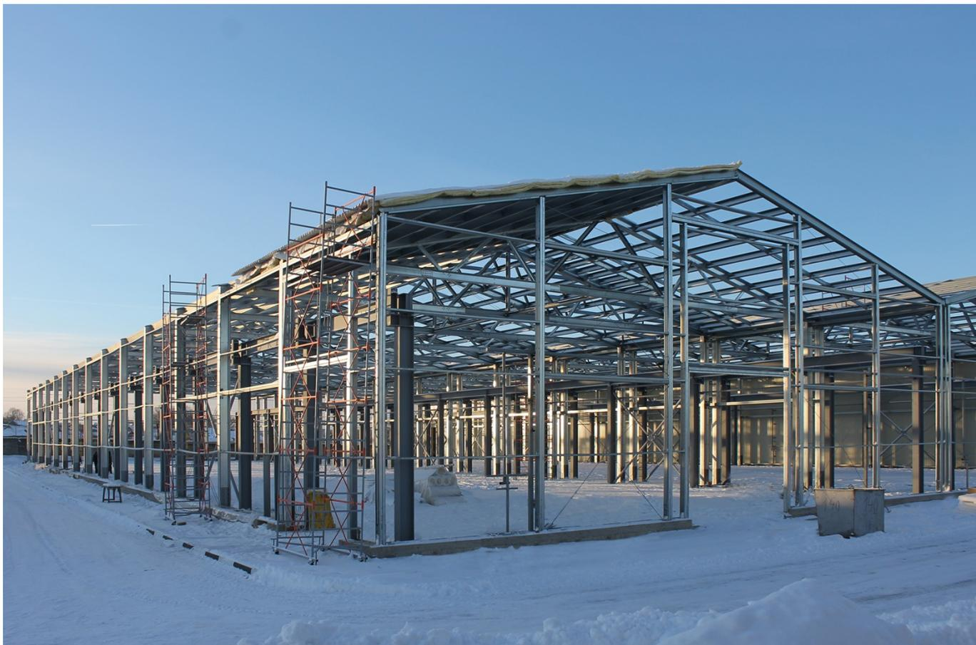
**Каркасы зданий СТЕРК® – ферменного типа с верхним шарнирным сопряжением колонн с фермой. Опирание колонн и стоек на фундамент – точечное, соединение жесткое. Устойчивость каркаса в поперечном направлении обеспечивается жесткостью поперечника, в продольном направлении – системой вертикальных связей и распорок.**
