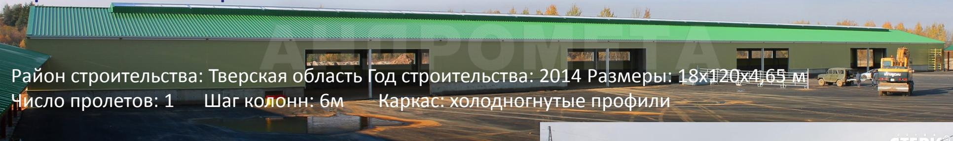
Район строительства: Тверская область Год строительства: 2014 Размеры: 18x120x4,65 м
