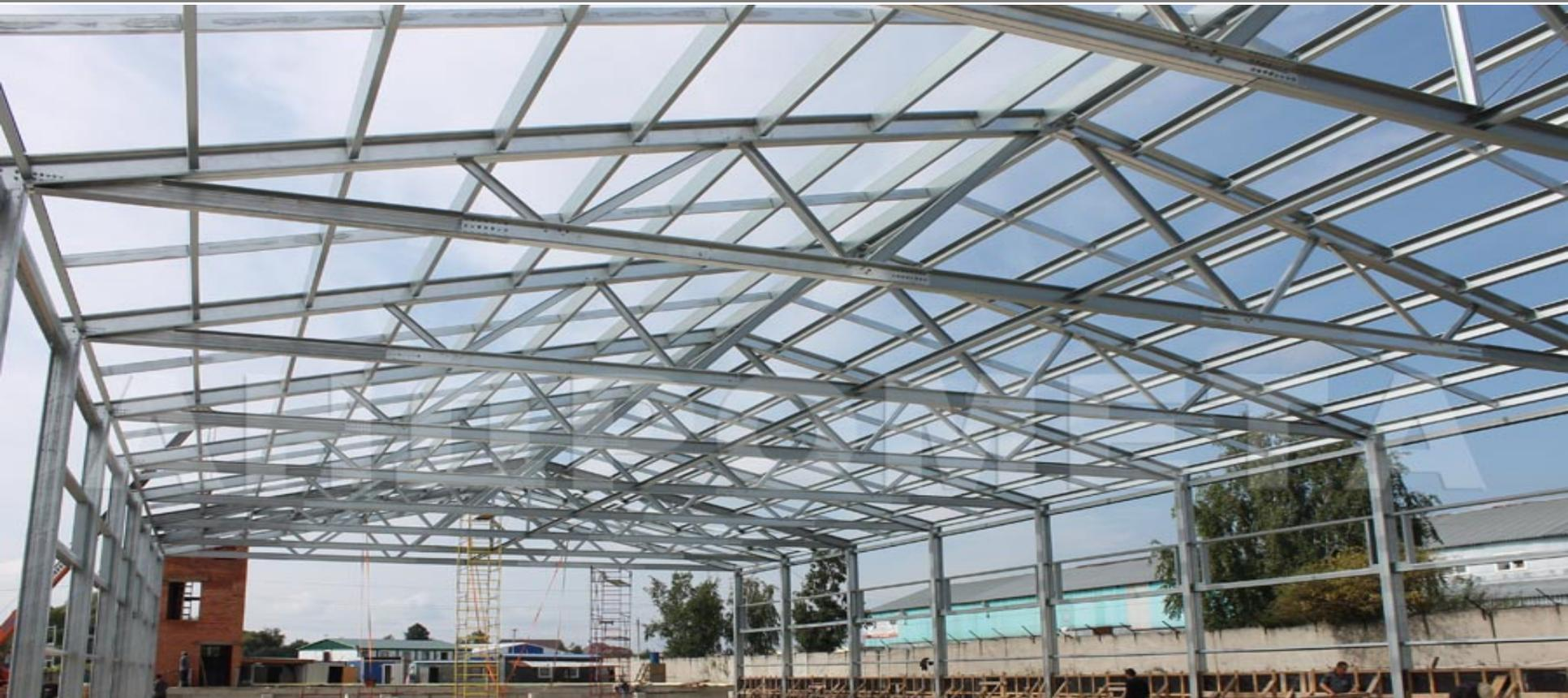
**Каркасы СТЕРК® изготавливаются из высококачественной отечественной горячеоцинкованной стали (С 345 по ГОСТ Р 52246-2004 с покрытием 275 г/кв.м). Все соединения – на болтах, сварка исключена. Соединительные узлы решены без применения фасонных элементов, что исключает использование деталей из черного металла. Это повышает уровень защиты каркаса от коррозии и гарантирует длительный срок его службы.**
