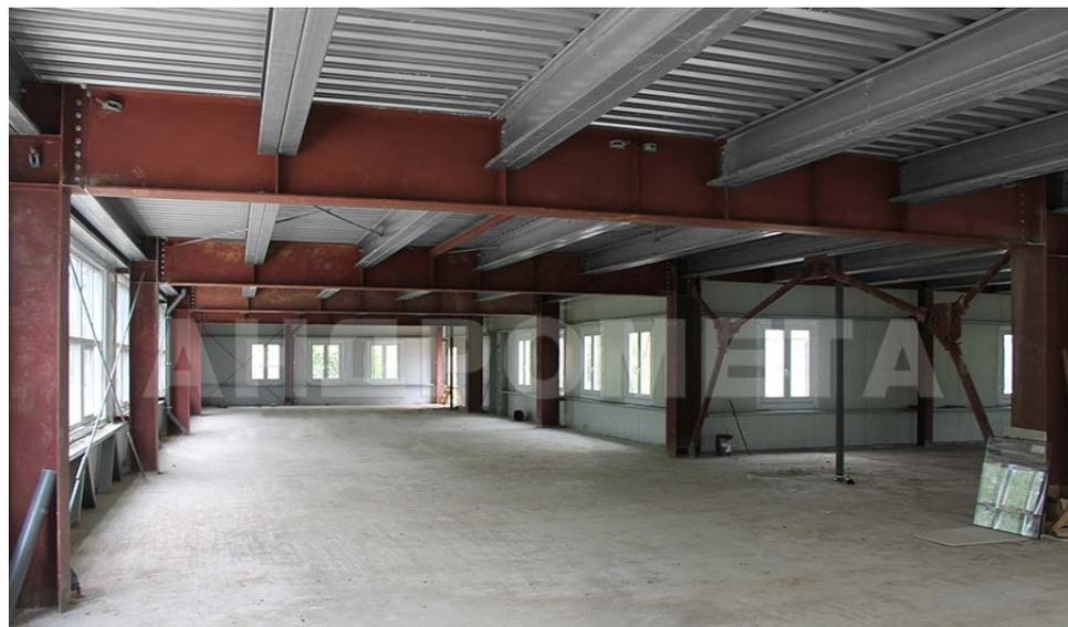
В таких случаях компания «Андромета» проектирует и поставляет комбинированные металлокаркасы - с полной или частичной заменой несущих конструкций из тонкостенных оцинкованных профилей конструкциями из «черного» металла. При выборе схемы здания проектировщики, исходя из комплекса технических и экономических критериев, находят оптимальное решение, позволяющее реализовать проект максимально эффективно.
