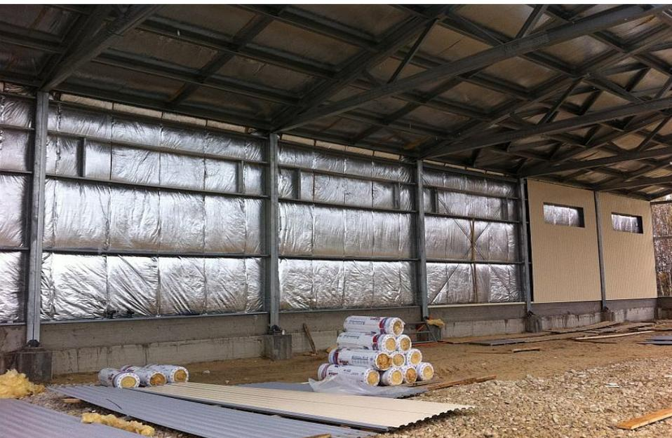
Компания «Андромета» предлагает экономичное и функциональное решение стеновых и кровельных ограждающих конструкций, подходящее для любых типов каркасов - полистовые сборки из профилированного листа и рулонного минераловатного утеплителя. По теплотехническим и гидрозащитным характеристикам они не уступают и даже превосходят сэндвич-панели, обладая значительно меньшей стоимостью и более высокой надежностью.
