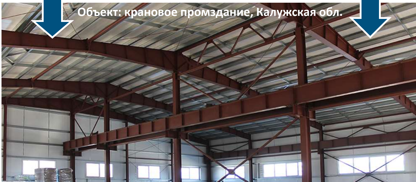
Сварная двутавровая балка
