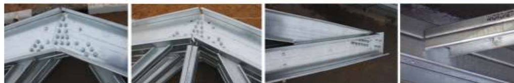
Укрупнительная сборка фермы и бесфасоночные узлы
