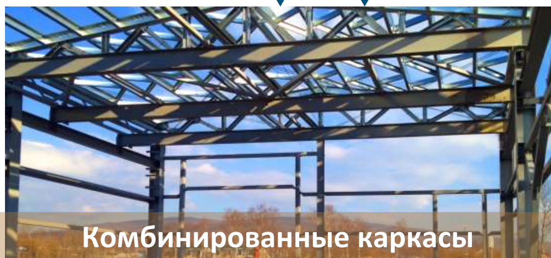
Каркасы из ЛСТК: пролет до 36 м, высота до 9 м
