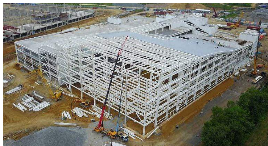
Монтаж металлоконструкций. Июнь 2017 г.
