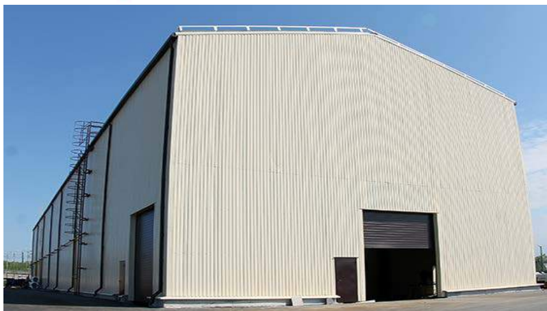
Цех № 5 завода «Андромета»: размеры 18 x 84 x 12 м Двухуровневая крановая эстакада
