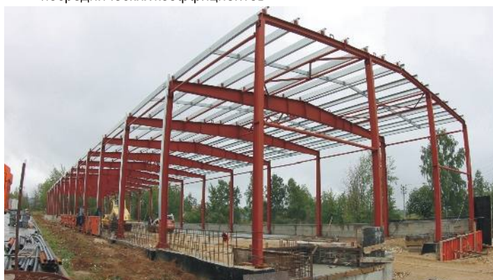
Объект: Складское здание, Московская область
