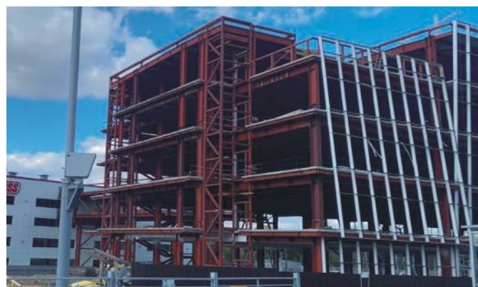
Объект: Торгово-развлекательный комплекс, г.Южно-Сахалинск
