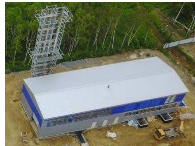
Построенная котельная. Июнь 2017 г.
