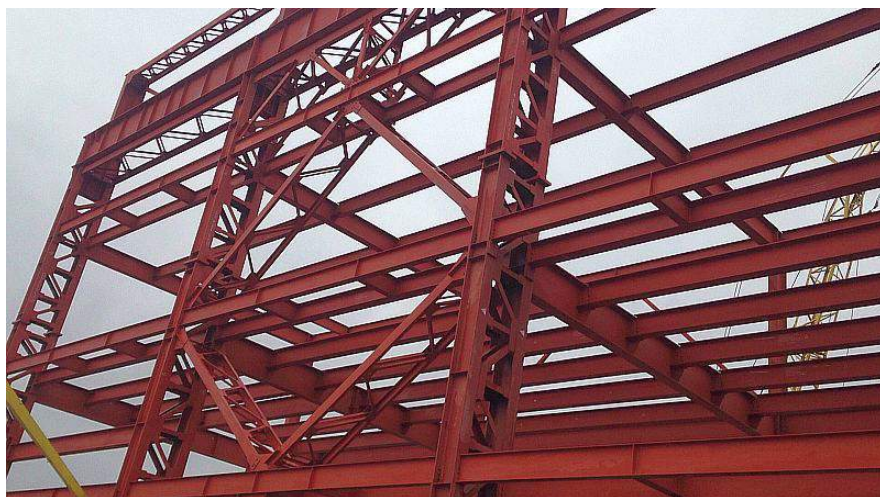
Монтаж конструкций Приморской ТЭС. Март 2018 г.
