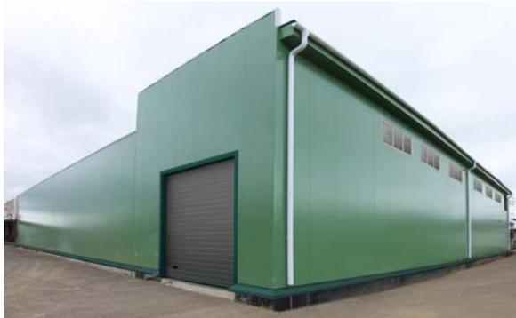
Учитывая необходимость встраивания новых зданий в структуру действующего птицекомплекса, важным преимуществом металлоконструкций производства ООО «Андромета» была их максимальная заводская готовность, что позволило сократить объемы и сроки строительных работ на объекте.
