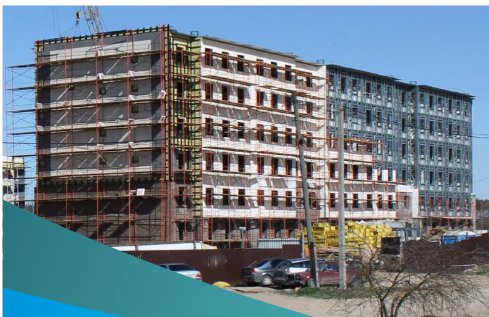
монтаж несъемной опалубки
